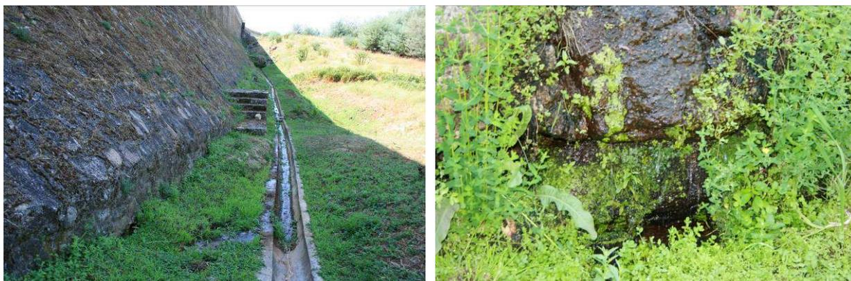
Figura 5 – Barragem da Póvoa. Infiltrações ao longo do corpo da barragem da Póvoa (Agosto 2009).
